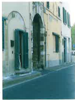
Vista dell'arco dalla fonte del Bardena
