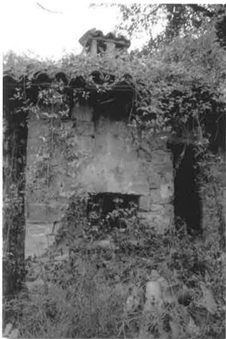
PRUNARO DI SOPRA
